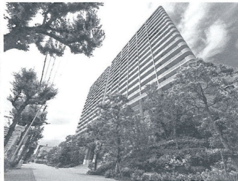
リバーガーデン福島 木漏れ日の丘、日本最大規模の津波避難ビルで約4500人が避難できる
