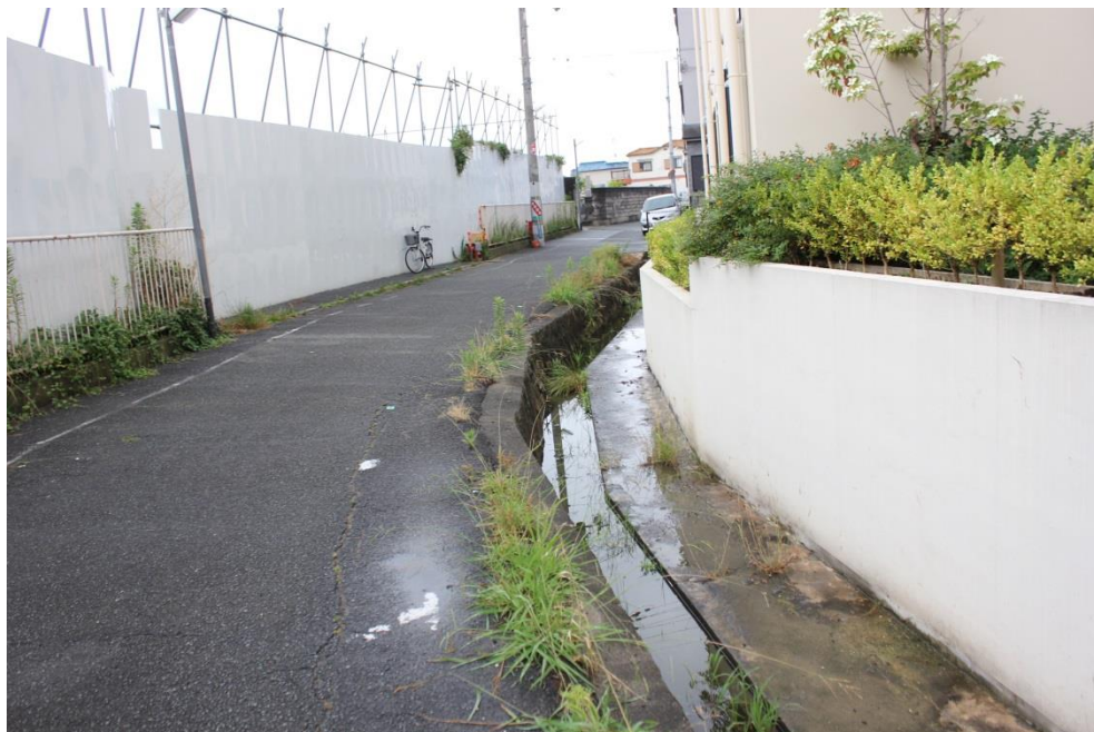
【BEFORE】現在の西側道路
